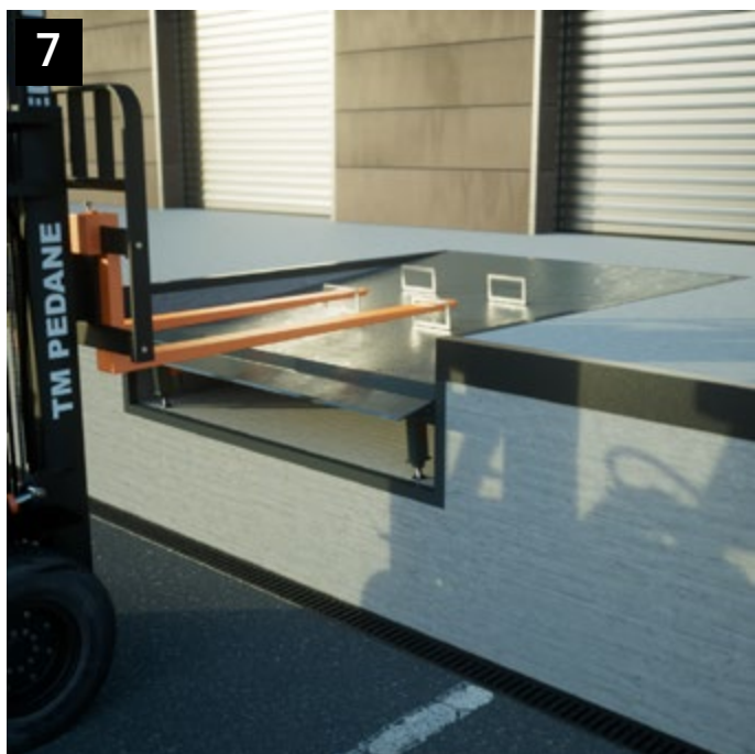
7 Arretrare leggermente il muletto affinché si sfilino le forche dai 2 golfari posteriori, dopodiché appoggiare delicatamente la rampa sulla fossa / Slowly reverse the forklift to disengage the forks from the two rear eyebolts, then carefully lower the ramp onto the pit.
