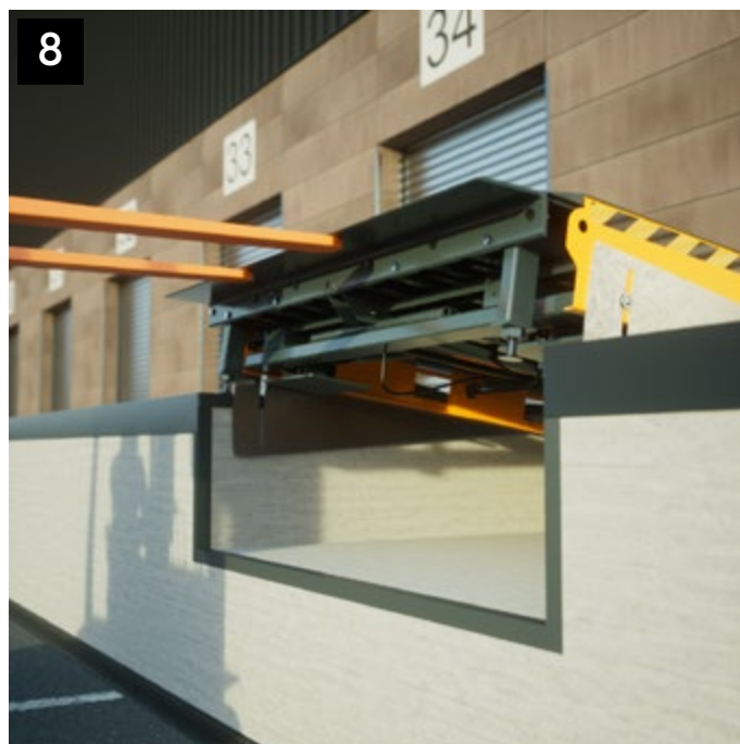
8 Ora porre le forche sotto l'unghia e sollevare di nuovo la rampa puntellandola mettendola in sicurezza / Now position the forks under the lip and lift the ramp again, propping it up to secure it safely.
