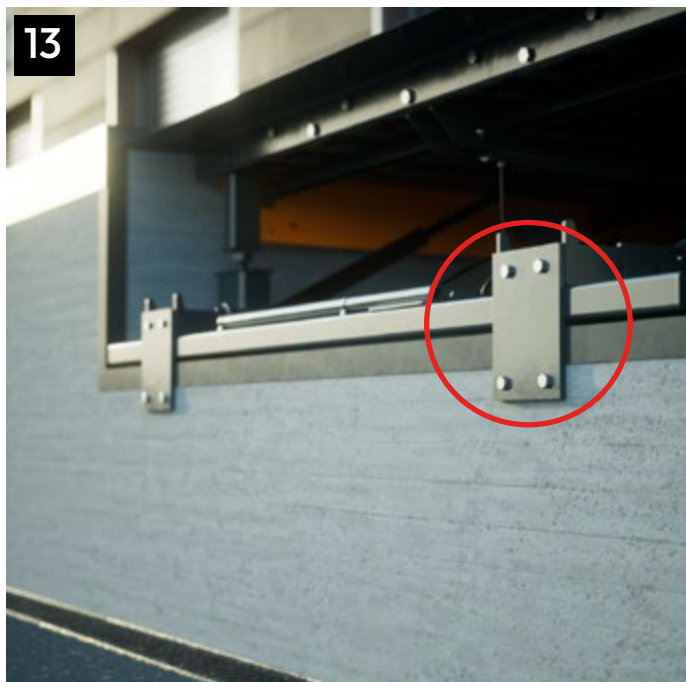
Installare le due piastre rettangolari in dotazione e tassellare sulla faccia frontale della banchina / Install the two supplied rectangular plates and anchor them to the front face of the dock.
