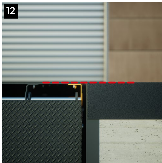
12 Sollevare tutta la rampa dall'ancoraggio anteriore (compreso) finche il pianale non è in piano con la banchina / Lift the entire ramp, including the front anchorage, until the deck is level with the dock.
