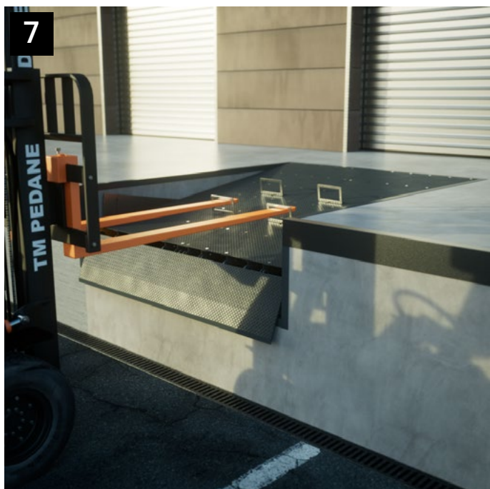
7 Arretrare leggermente il muletto affinché si sfilino le forche dai 2 golfari posteriori, dopodiché appoggiare delicatamente la rampa sulla fossa / Slowly reverse the forklift to disengage the forks from the two rear eyebolts, then carefully lower the ramp into the pit.
