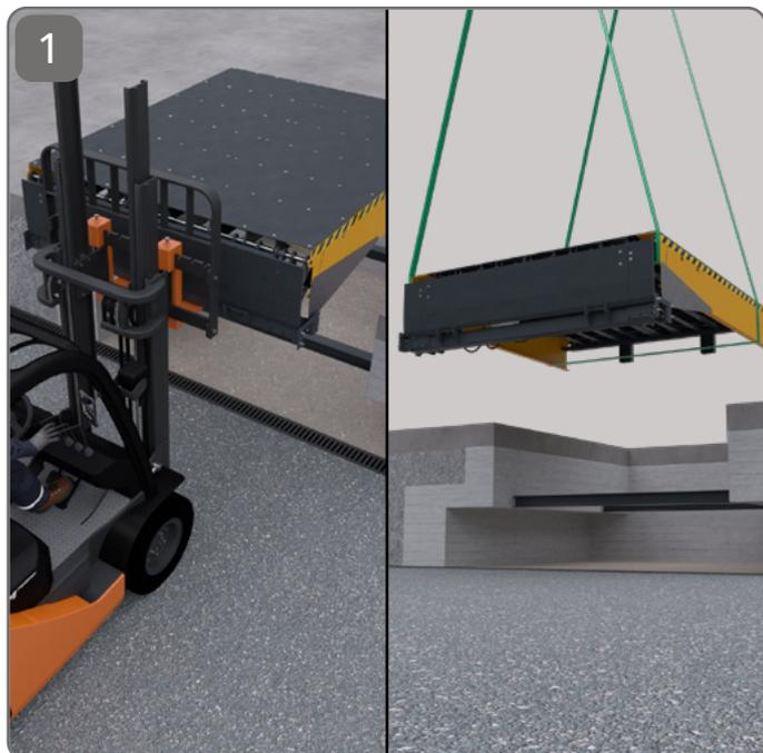
La rampa può essere movimentata per mezzo di un muletto o funi di adeguata resistenza / The ramp can be moved by forklift or ropes of adequate strength
