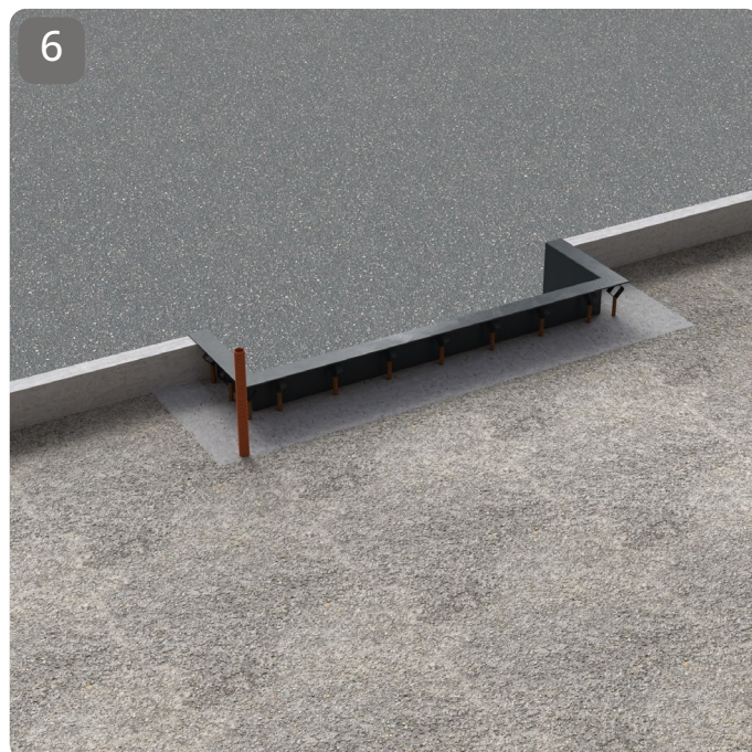
Portare a livello con inerte. / Level with aggregate.
